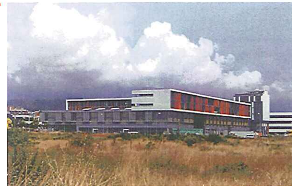
Edificio terciario El Rengle en Mataró, entregado en 2010.
